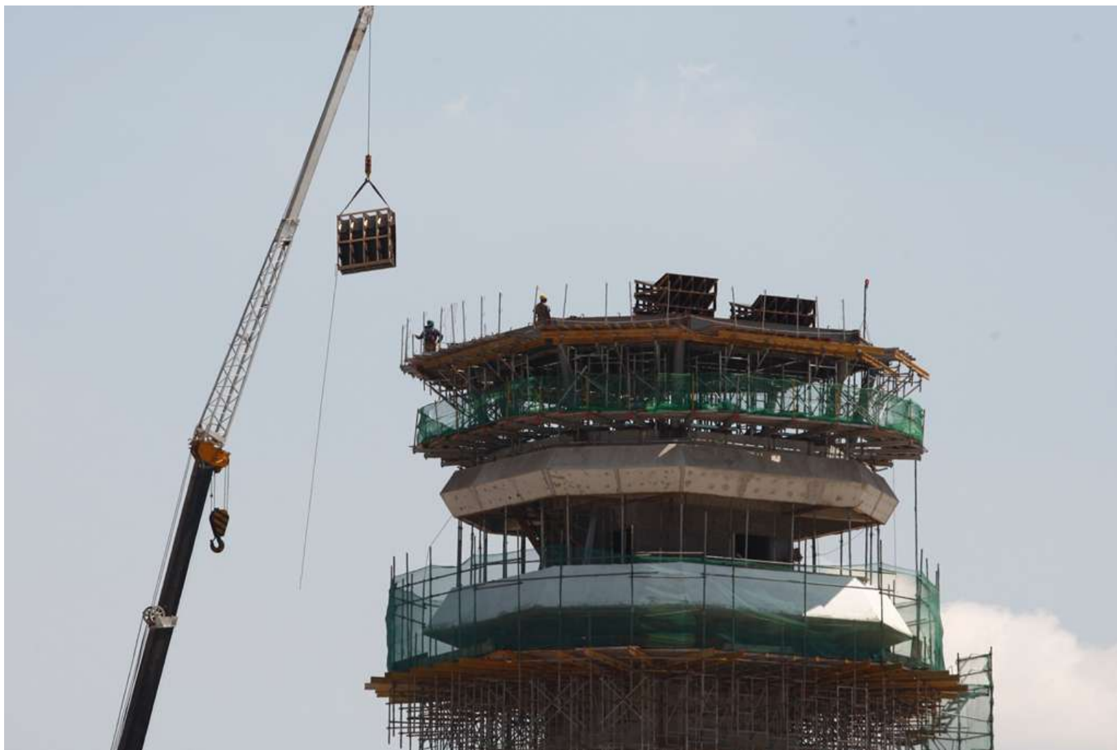
Nova torre de controle em obras
