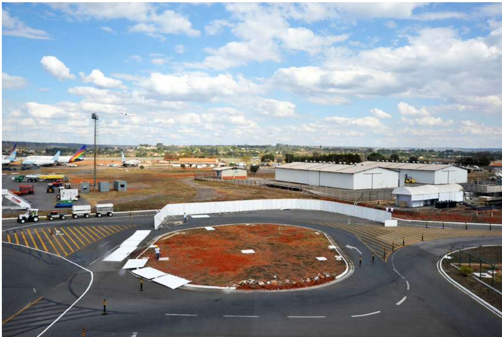
Módulo Operacional Brasília - Início das Obras Panorâmica
