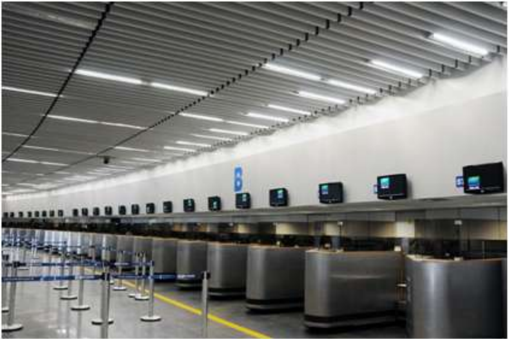
Reforma Terminal 1 - Testeiras Internas Depois
