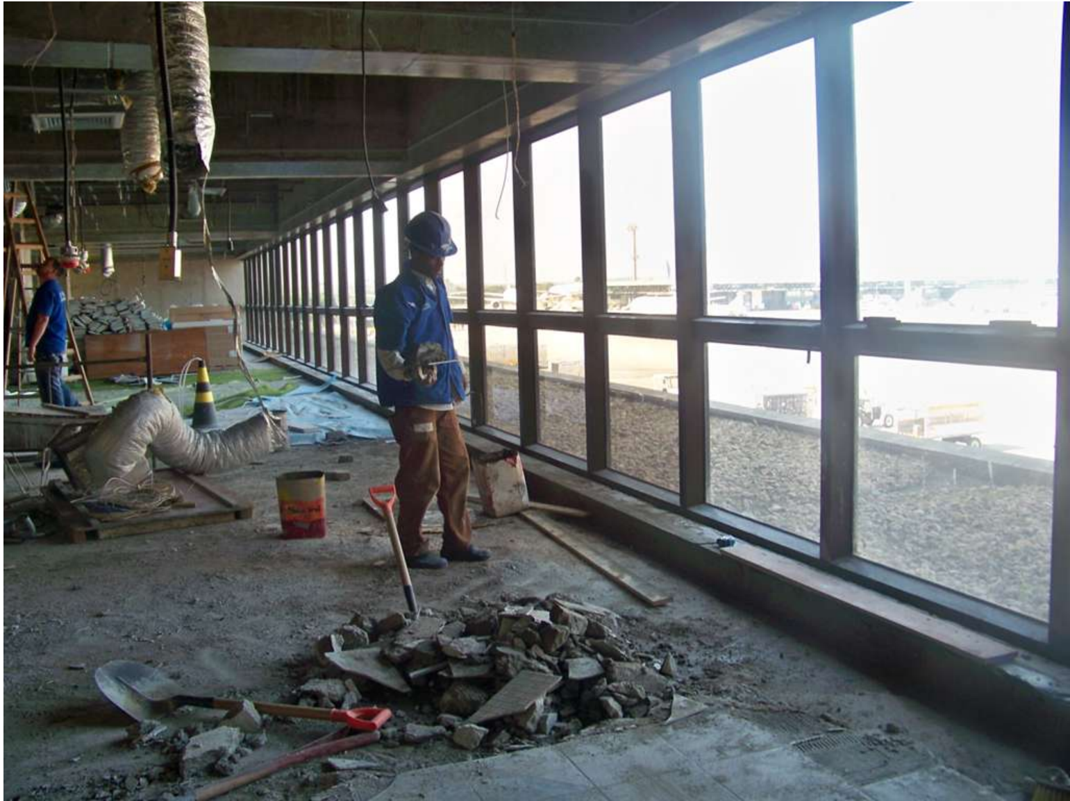
Obras Embarque (Dom. E Internacional)
