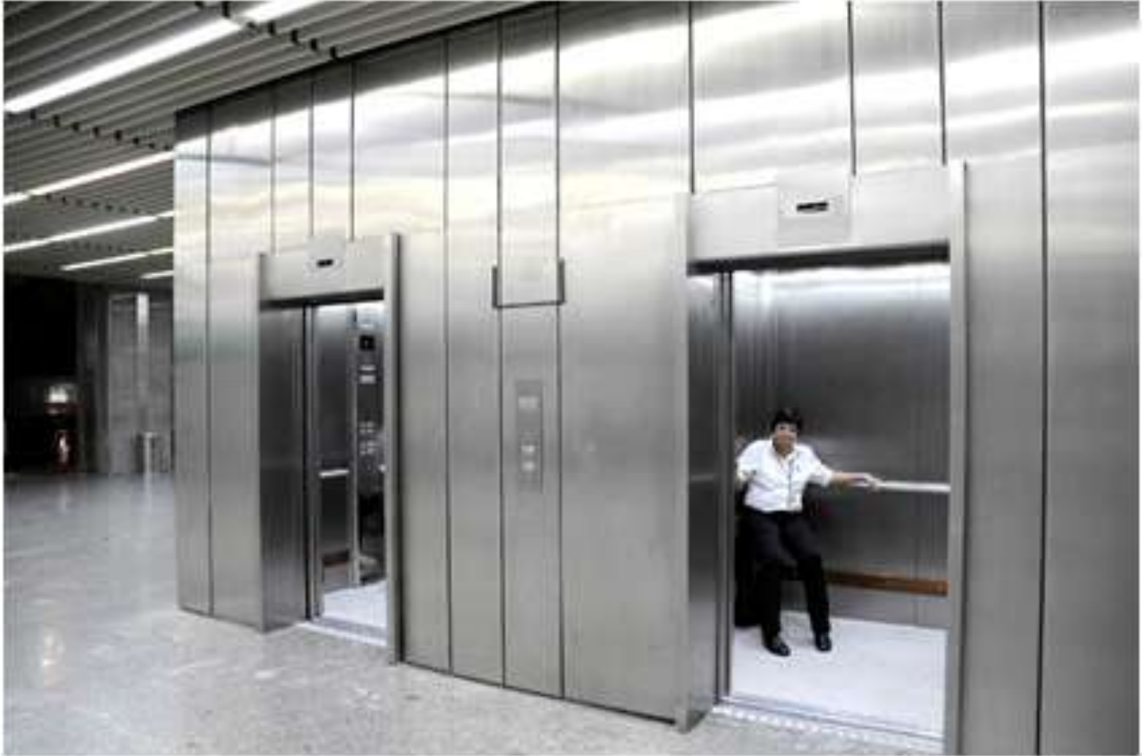
Reforma Terminal 1 - Elevador Depois
