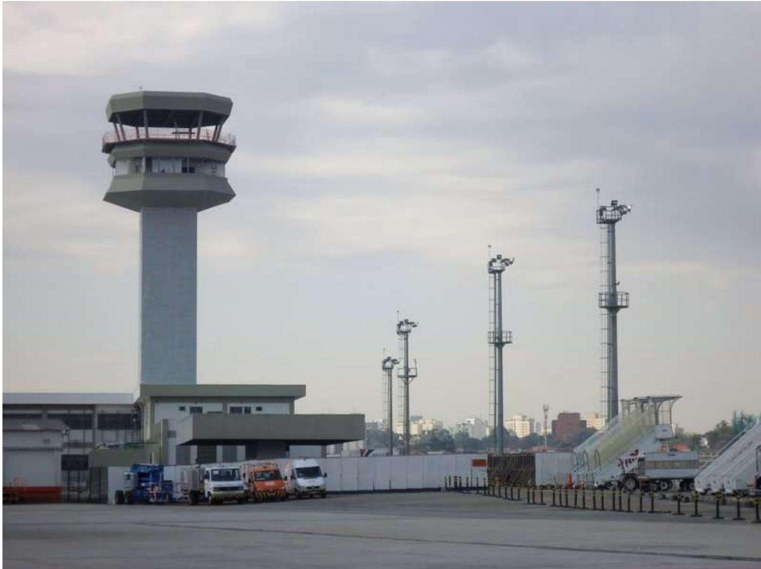
Nova torre de controle concluída
