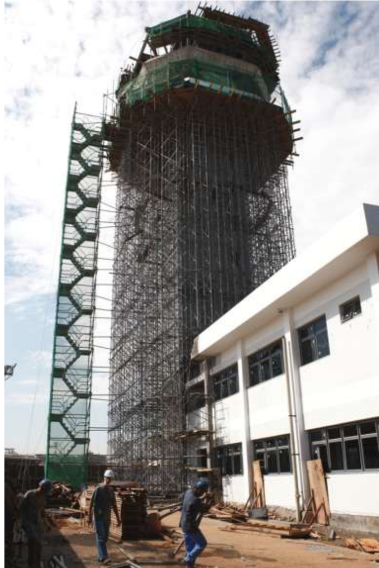
Nova torre de controle em obras
