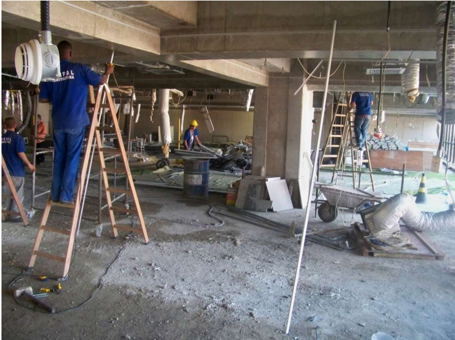
Obras Embarque (Dom. E Internacional)
