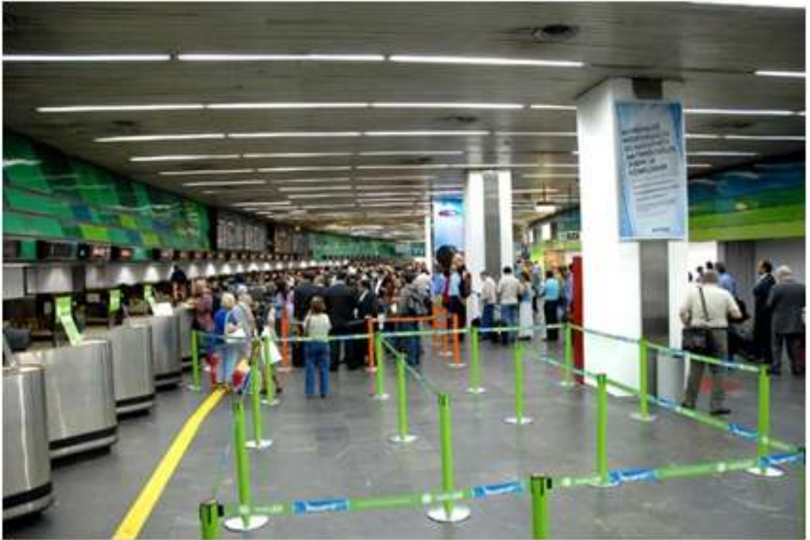
Reforma Terminal 1 - Setor A Antes
