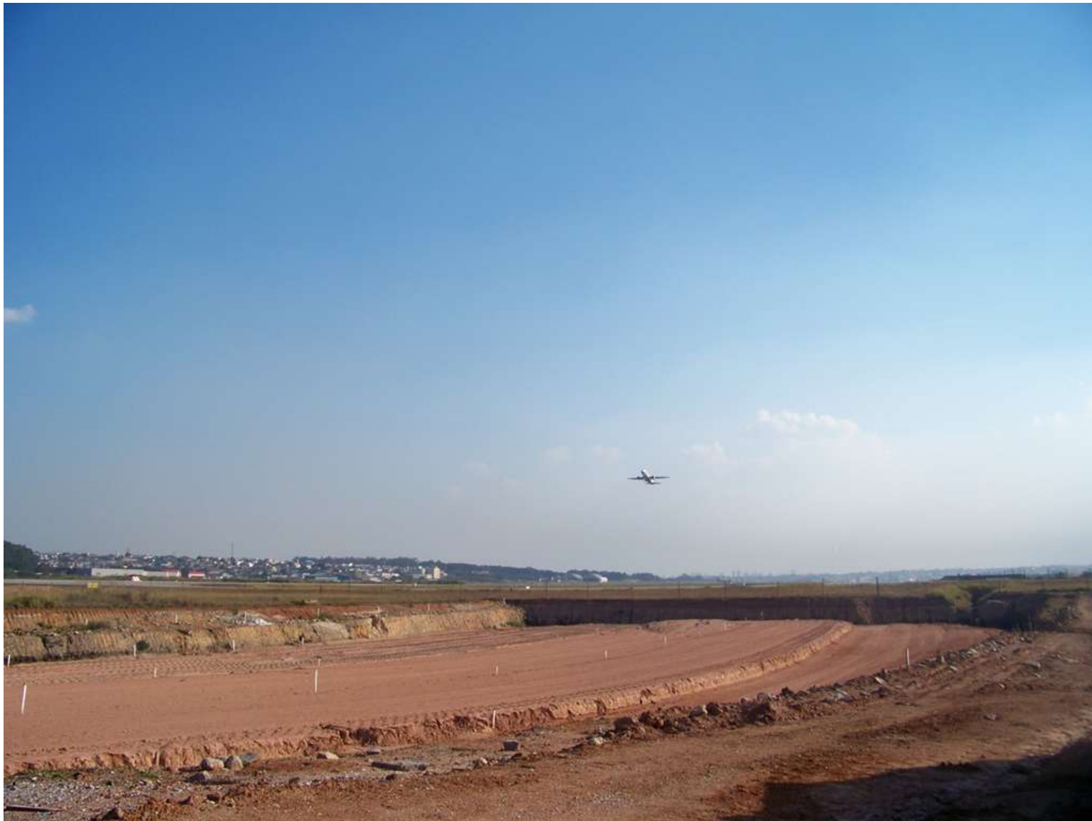
Obras Sistema de Pista e Pátio
