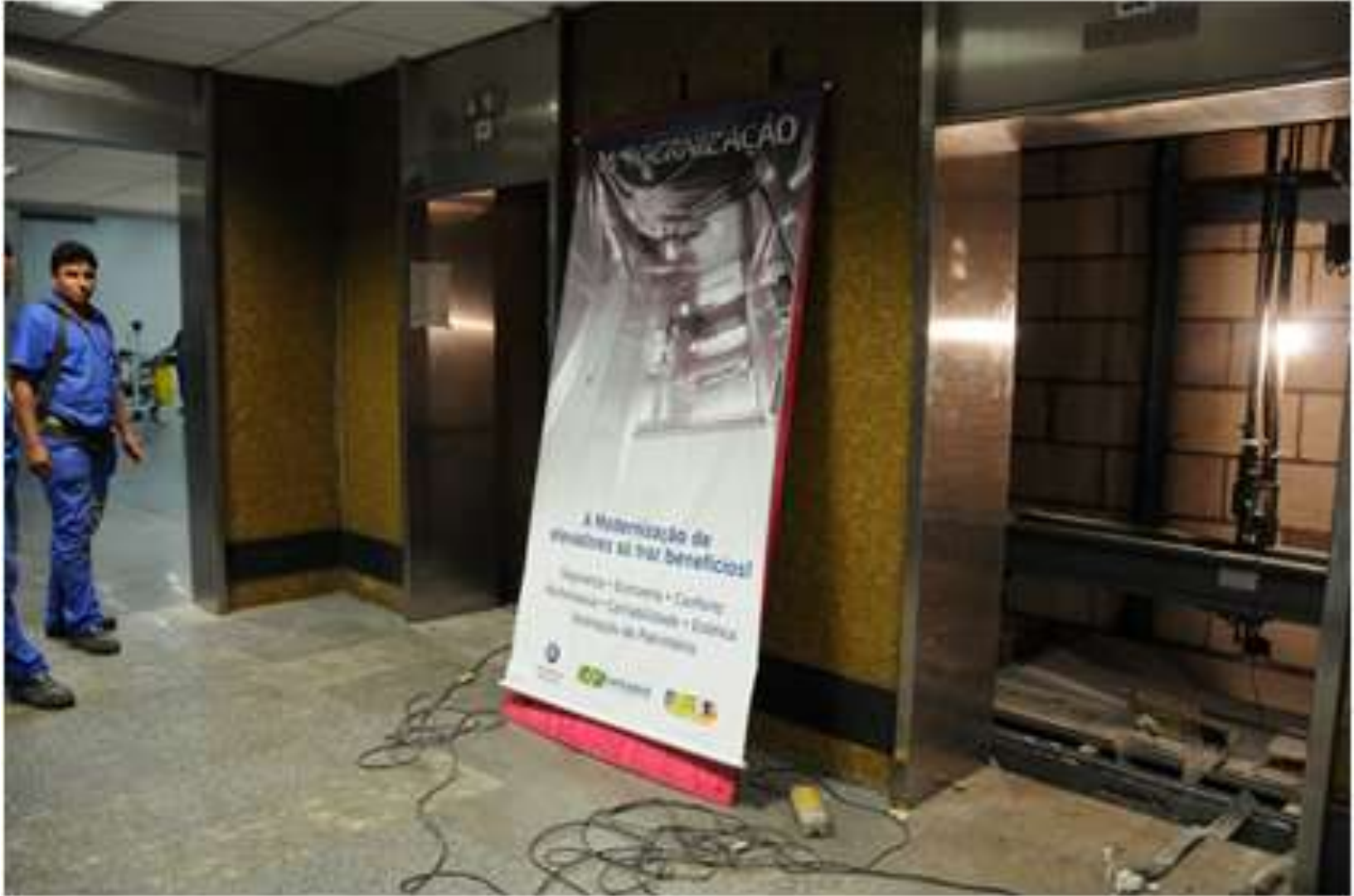
Reforma Terminal 1 - Elevador Antes
