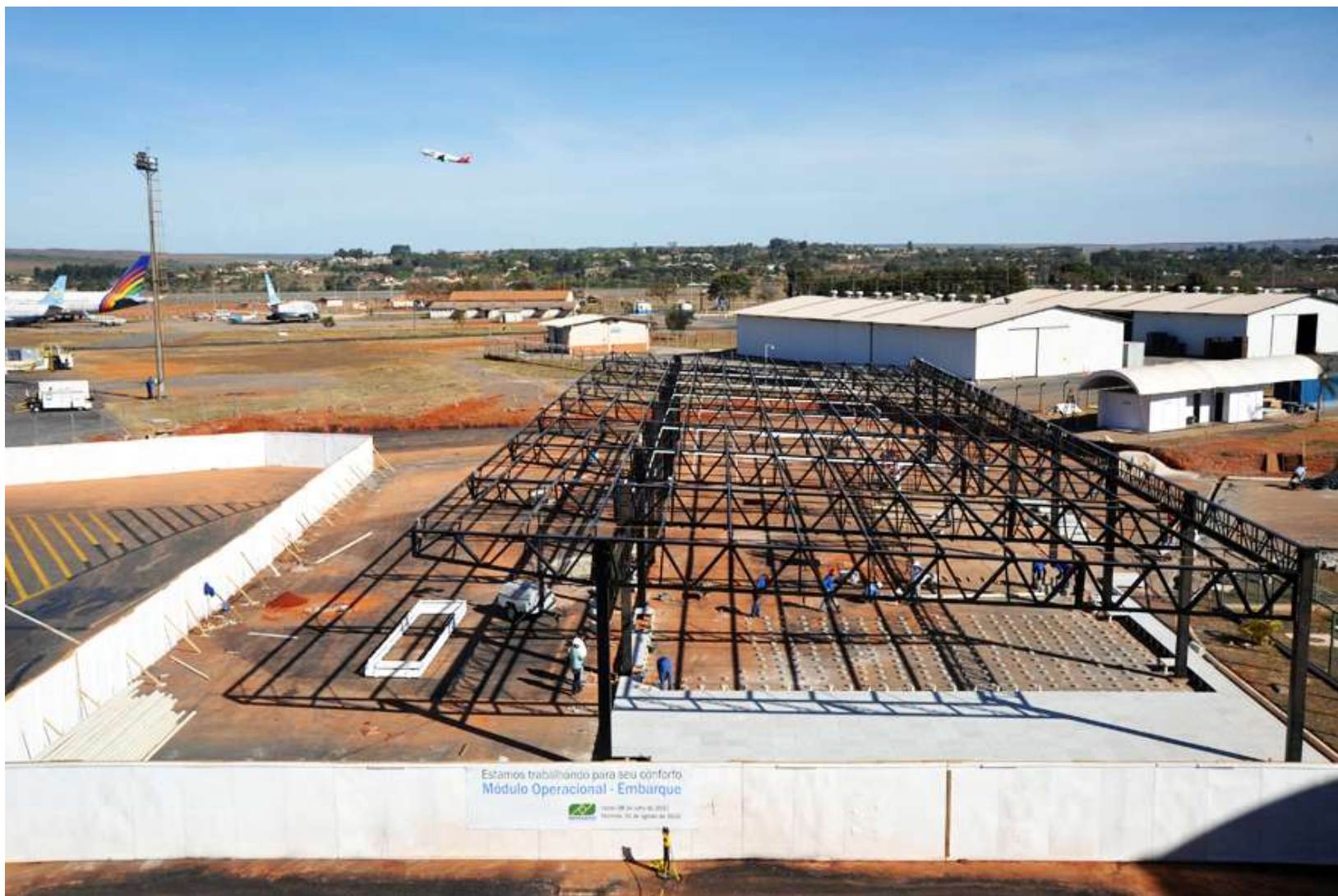
Módulo Operacional Brasília - Meio das Obras Panorâmica
