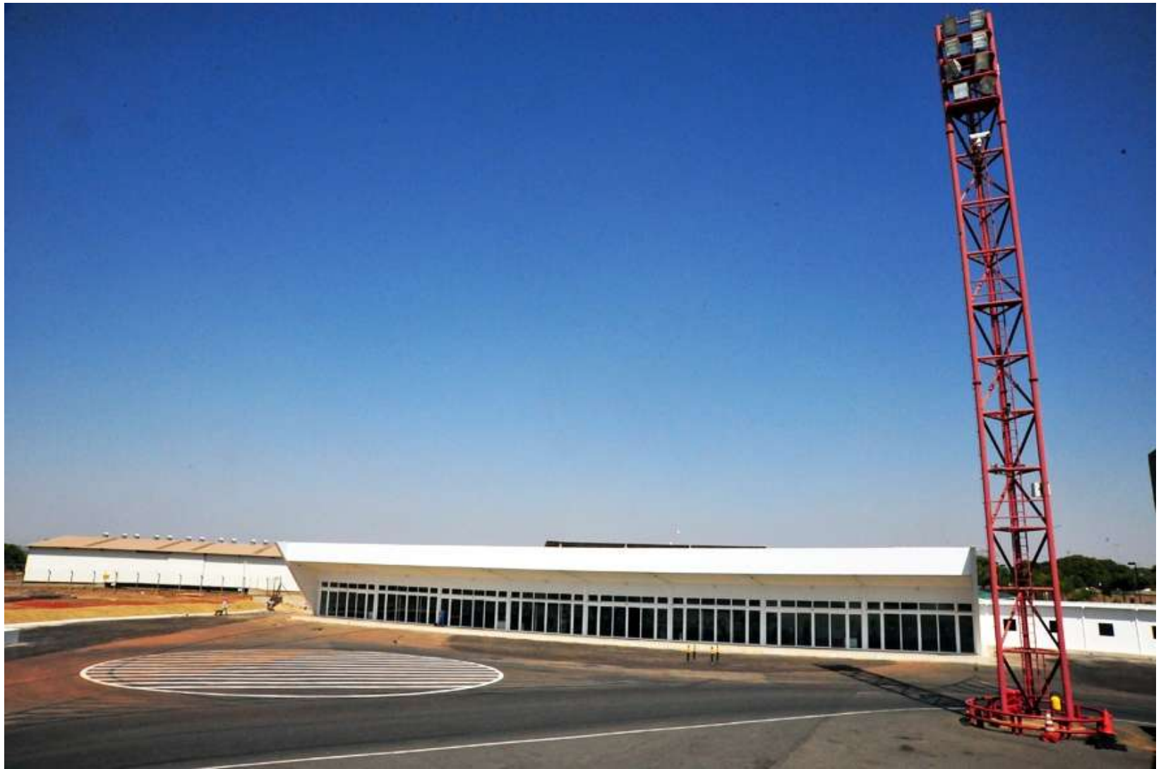
Módulo Operacional Brasília - Concluído Panorâmica
