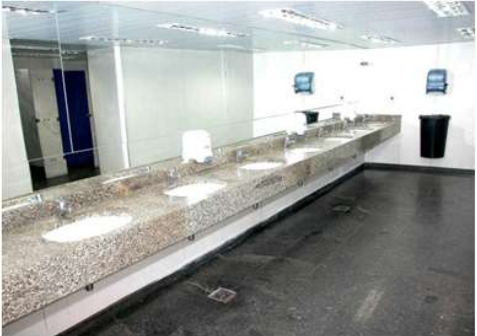
Reforma Terminal 1 - Banheiros Antes
