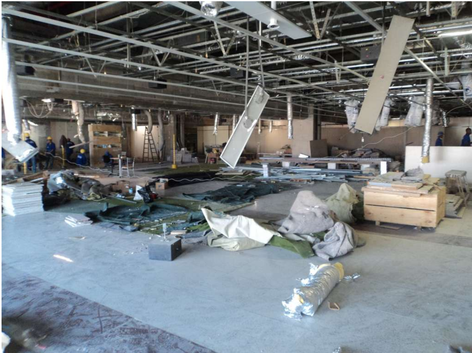
Obras Embarque (Dom. E Internacional)
