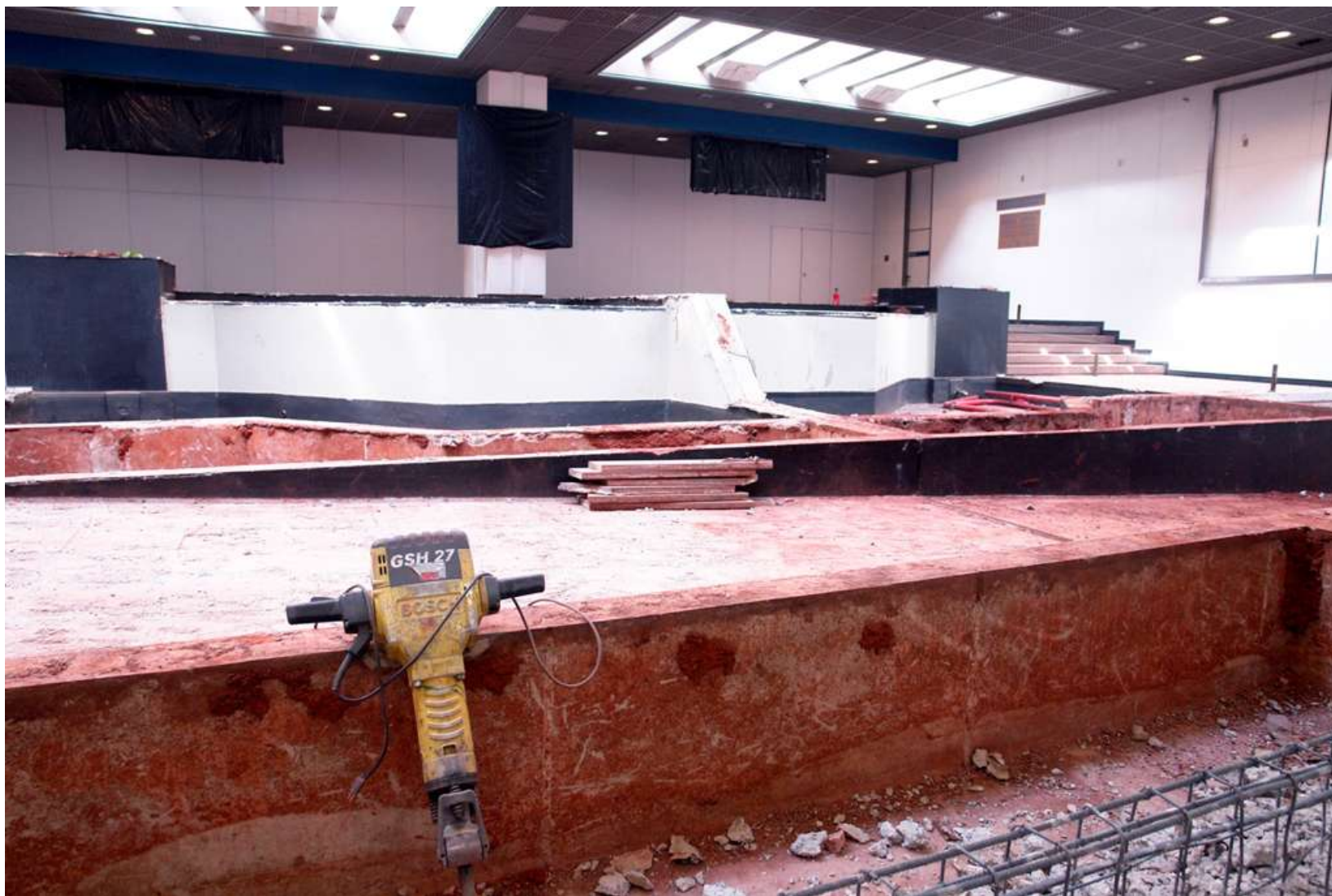
Reformas Terminal 1 Brasília
